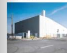
Station de réseau de chaleur
